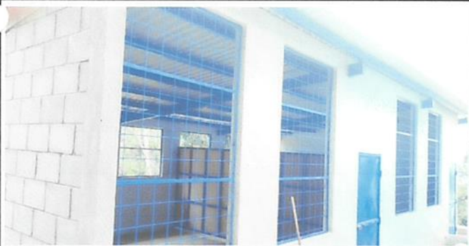
Foto 5: Finalización de paredes.
