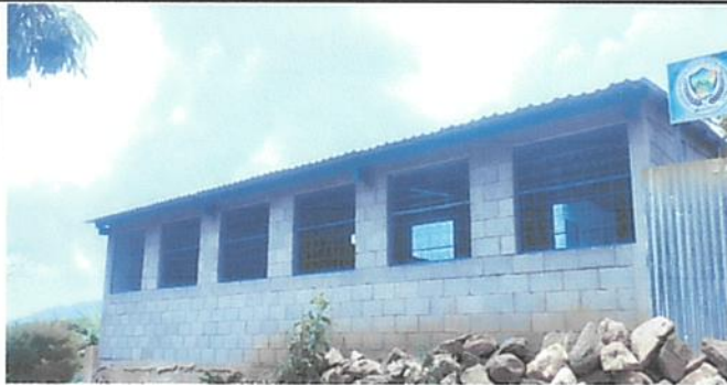
Foto 1: Colocación de ventanales.
