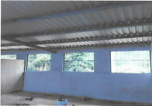
Foto 3: Colocación de material de soporte de techo.
